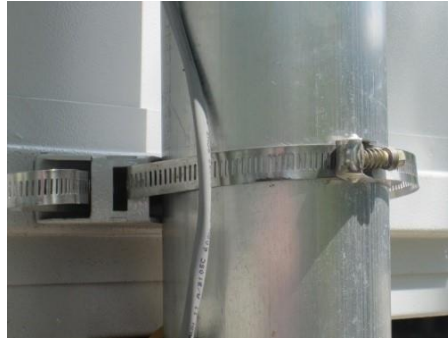
Figura 5 – Radar sujetado en poste usando Soporte Estándar
