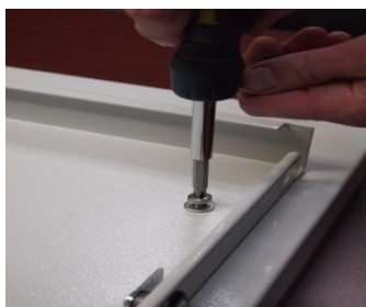
Figura 6 – Montando el Soporte Lado Radar
